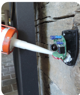
Étape 2 : siliconer à la sortie des fils
