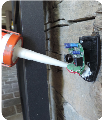
Étape 2 : siliconer à la sortie des fils
