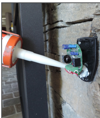
Etape 2 : siliconer à la sortie des fils
